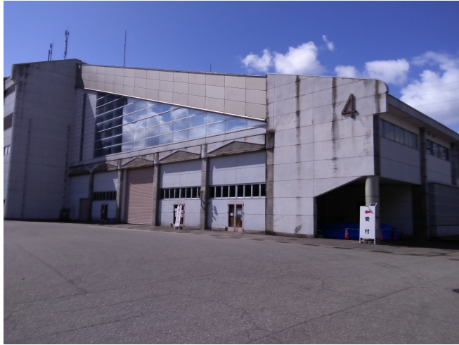
広域物資拠点 石川県産業展示館4号館
