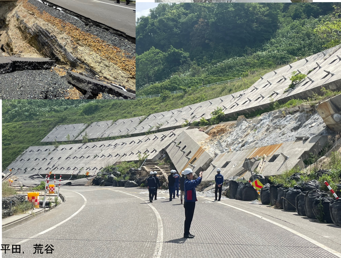
ループ部では 大規模な法面崩壊
